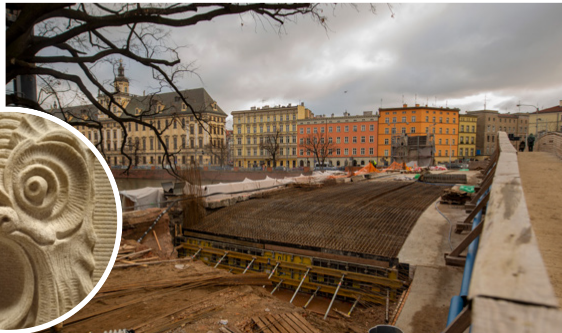
Rzeźby przedstawiające stwory wodne już po konserwacji, wkrótce powrócą na przeprawę
